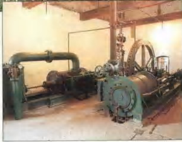
Die Dampfmaschine war nur Reserve – blicherweise bezog die Brennerei alle Energie ber ein Wasserrad.
